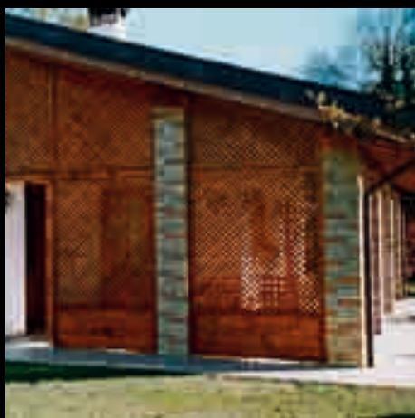
Tamponamento con grigliati a maglia fine
