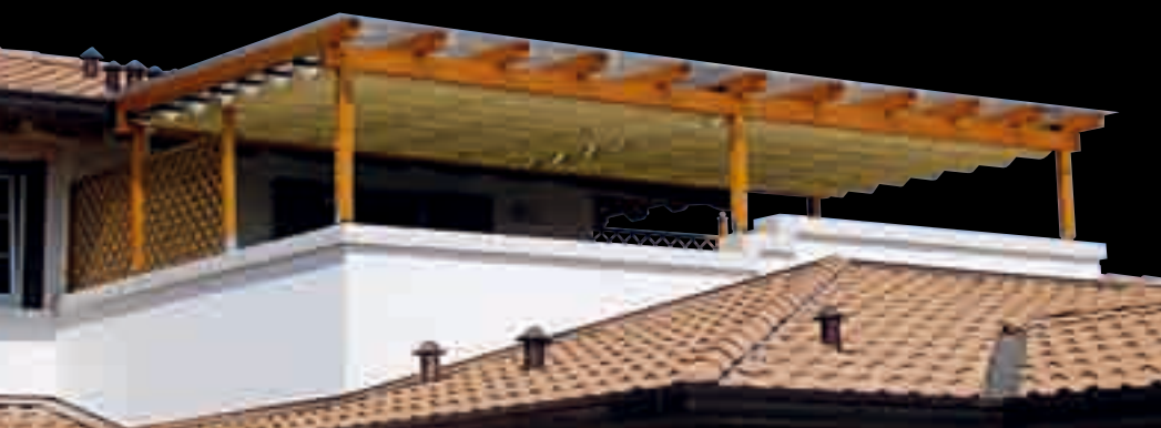
Tamponamento con grigliati a maglia fine
