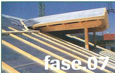
**.07** Distribuire i listelli per la ventilazione. Posati e fissati in senso perpendicolare alla gronda. Per ottenere una buona ventilazione, non superare la distanza fra un listello e l'altro di cm. 60 l'altezza del listello non deve essere inferiore a cm. 4 e non superiore a cm. 7.
